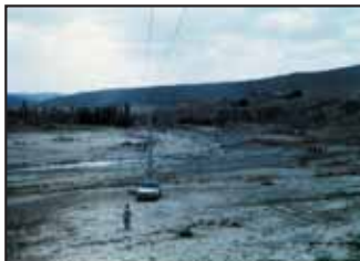
نمونه شبکه احداث شده در داخل رودخانه
