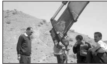
بازدید از مرحله نصب تیر و سیمکشی پروژه ها
